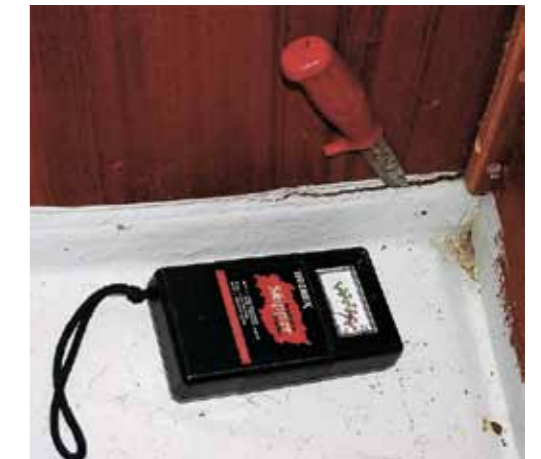
Diva 399 -91 Fart okänd. Troligen en rak träff framifrån. Bilden tagen i babords stuv i salongen. Huvudskottet har slitits loss från fastplastningen i botten ända bort till styrbords sida och fukt har trängt in i sandwichlaminatet.
